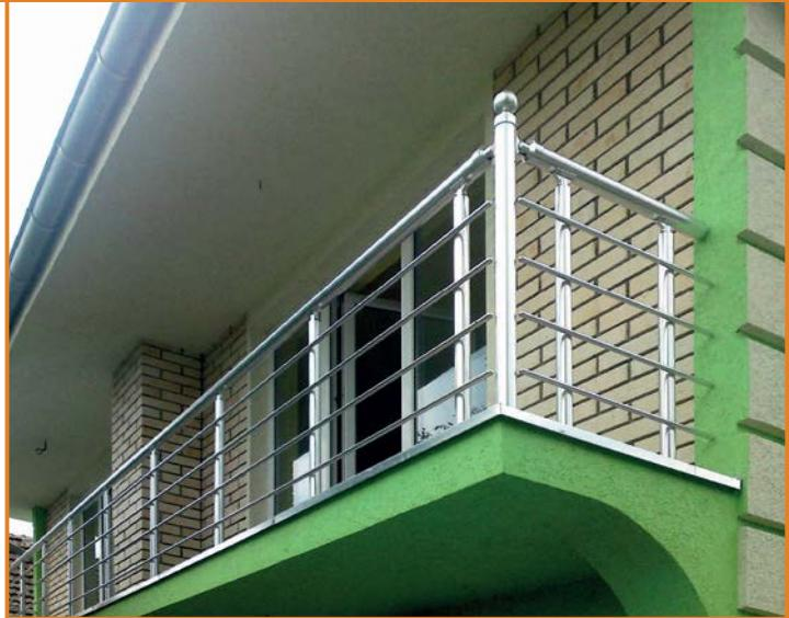
Model ograde "4+1" se pravi od aluminijumskih cevi. Rukohvat je Ø 50 mm, 4 cevi u polju ograde su Ø 16 mm, stubovi Ø 40 mm, visina ograde od 95 do 98 cm, ankeri 50 cm. Ankeri su zbog stabilnosti i čvrstine ograde duži od standardnih.
