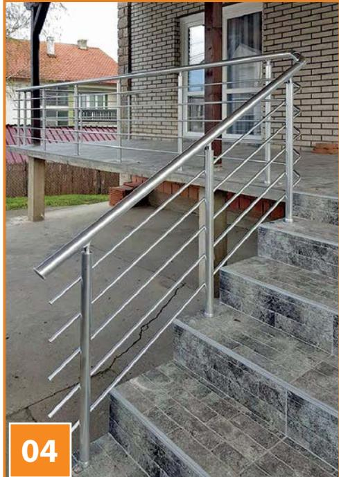
Model ograde "5+1" se pravi od aluminijumskih cevi. Rukohvat je Ø 50 mm, 5 cevi na ogradi su Ø 16 mm, stubovi Ø 40 mm, visina ograde od 95 do 98 cm, ankeri 50 cm. Ankeri su zbog stabilnosti i čvrstine ograde duži od standardnih.
