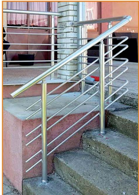
Model gelendera "3x2" se pravi od aluminijumskih cevi. Rukohvat je Ø 50mm, cevi na gelenderu Ø 16mm, stubovi Ø40mm, visina ograde od 95 do 98 cm, a dužina ankera je 50cm.
